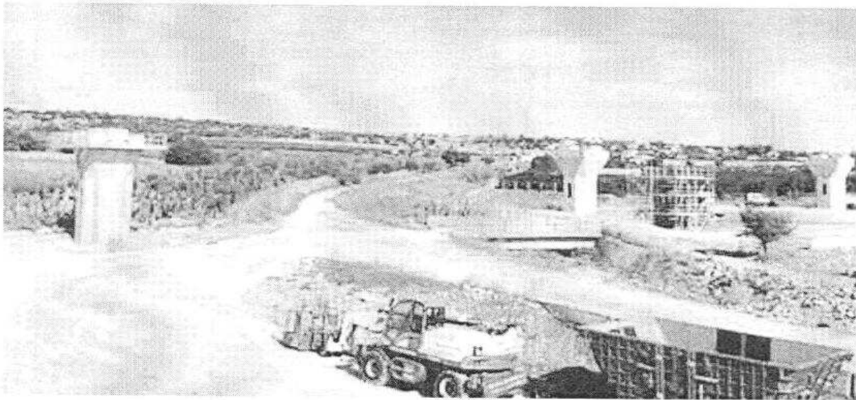
Il cantiere dei lavori in corso sulla Sr-Rg-Gela nel tratto Rosolini-Modica
